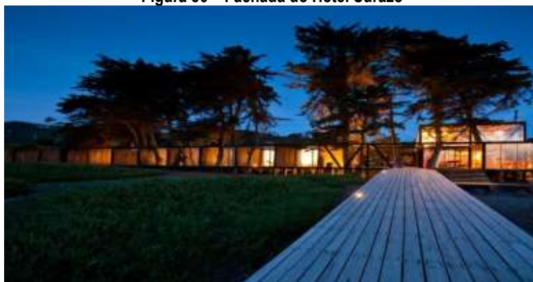
Figura 86 – Fachada do Hotel Surazo
