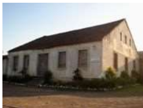
Figura 23 – Casa de Pedra
