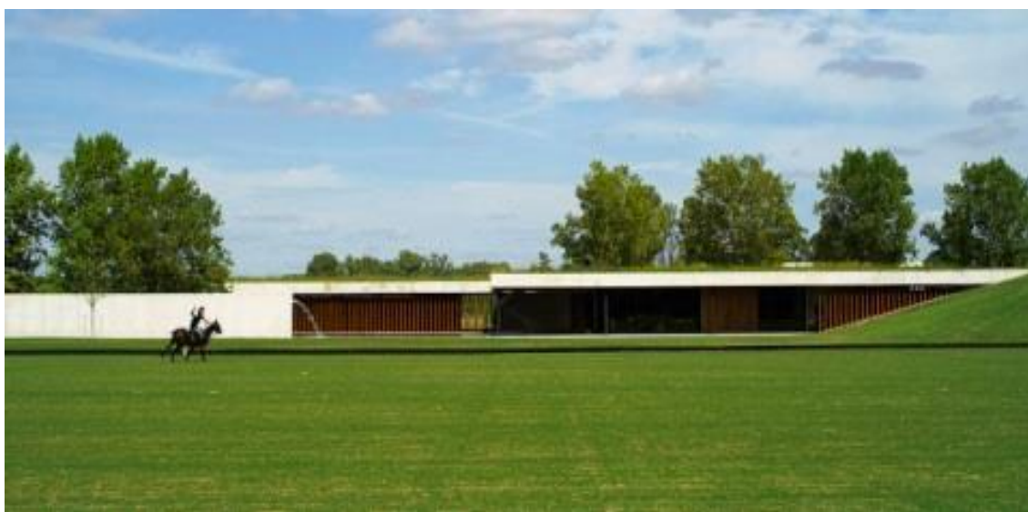
Figura 65: Fachada voltada para o campo de polo.
