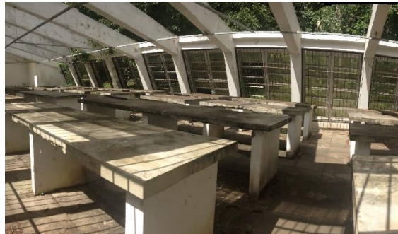
Figura 34 - Viveiro de samambaias, vista interna
