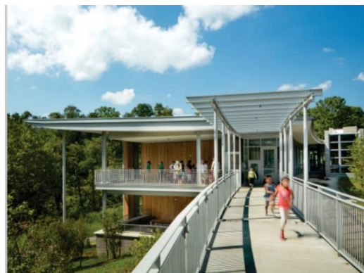
Figura 62 - Passarelas de acesso
