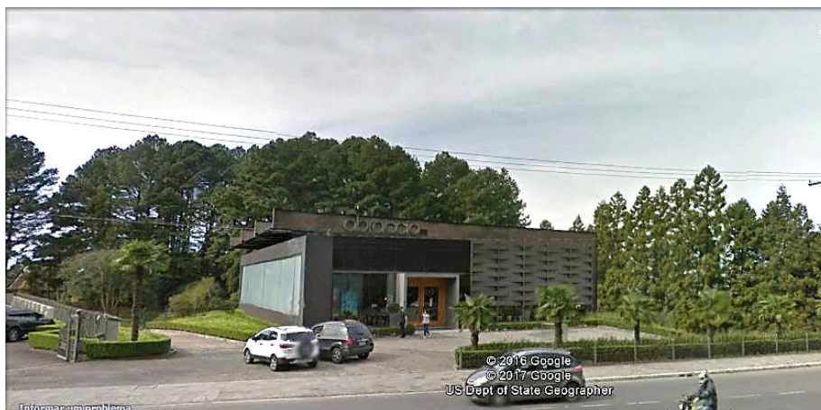
Imagem 50: Entorno com construções contemporâneas.
