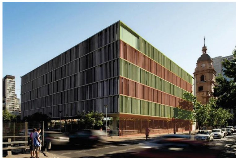
Figura 58 – Fachada do Edifício.
