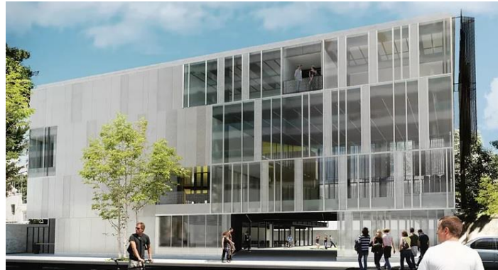
Figura 38 – Fachada do Edifício.
