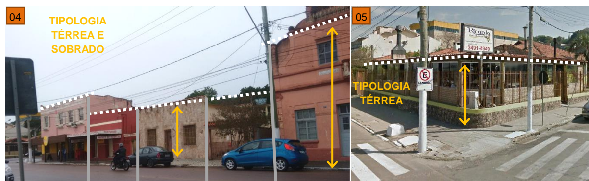
Figura 29 - Trechos de fachadas 04 e 05
