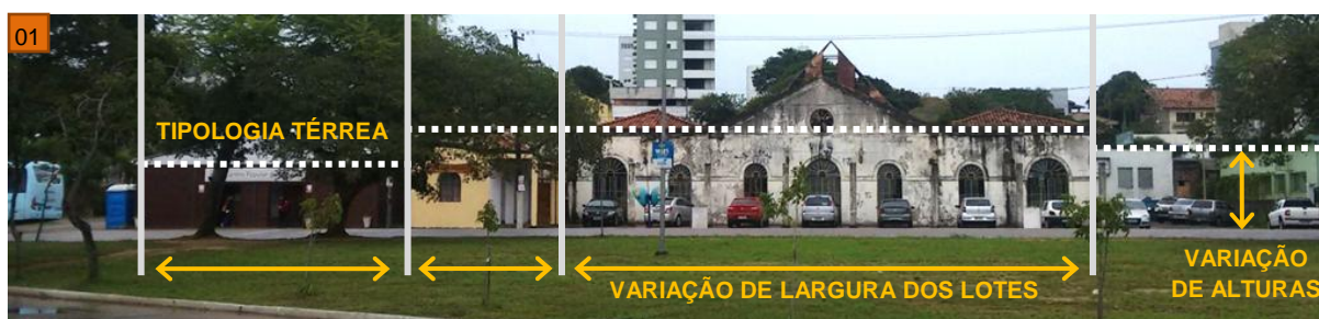
Figura 27 - Trecho de fachada 01
