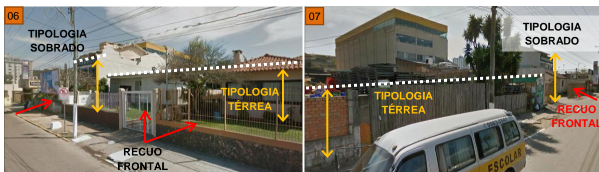
Figura 30 - Trechos de fachadas 06 e 07
