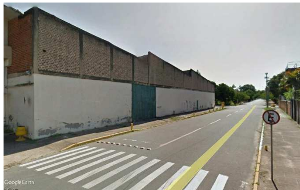
Figura 22 – Antiga construção sobre o lote
