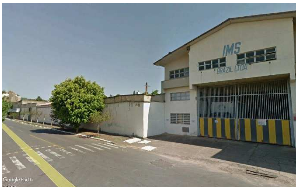
Figura 21 – Antiga construção sobre o lote
