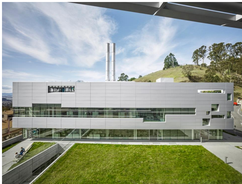
Imagem 17 – Chu Hall fachada
