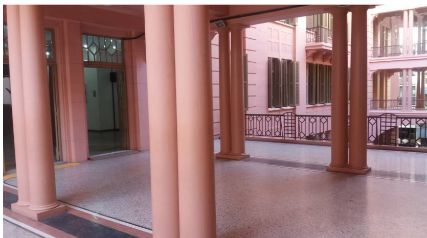
Figura 3 – CCQM: Vista das passarelas.
