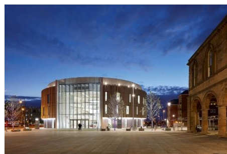
Figura 64: Fachada do centro
