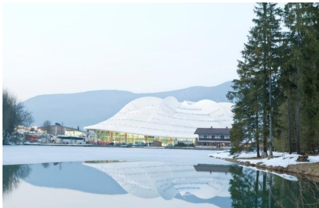
Figura 54: Vista externa com entorno próximo
