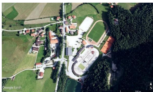
Figura 49: Vista aérea da arena antes da reforma, pista sem cobertura
