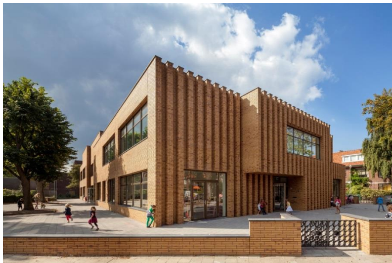
Figura 49 – Foto Fachada Sul e Leste
