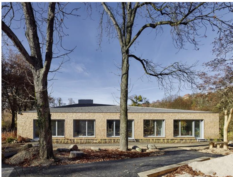
Figura 41 – Foto da fachada leste
