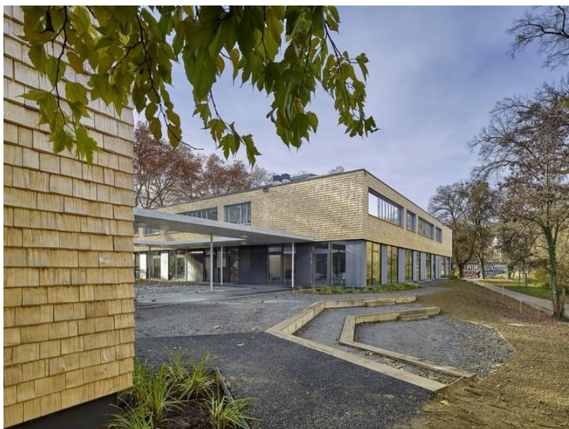
Figura 40 – Foto da fachada sul
