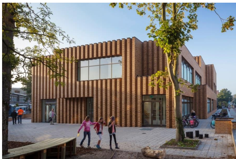
Figura 50 – Foto Fachada Norte e Leste
