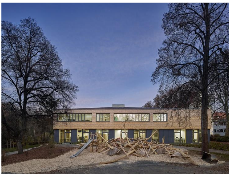
Figura 42 – Foto da Fachada Leste
