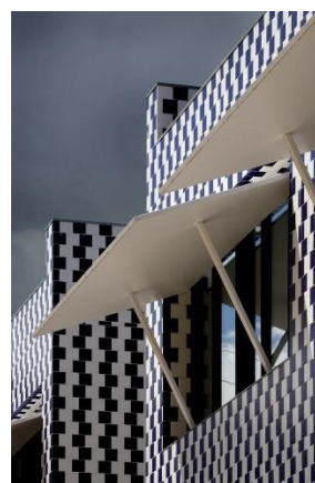
Figura 74 – Beirais inclinados.
