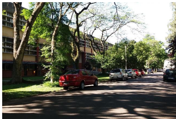
Figura 27 – Prédio da Fundação (2) – a.
