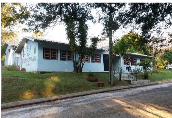
Figura 34 – ITEL – Prédio atual (7).
