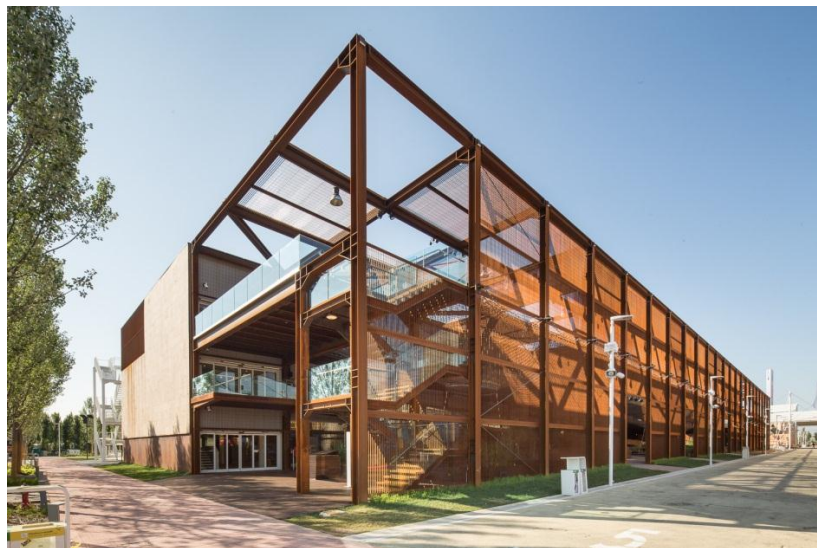
Figura 49 – Fachada com estrutura de cobertura
