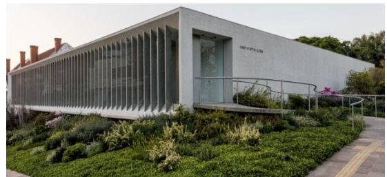
Figura 5 – Fachada Sudoeste Instituto Ling
