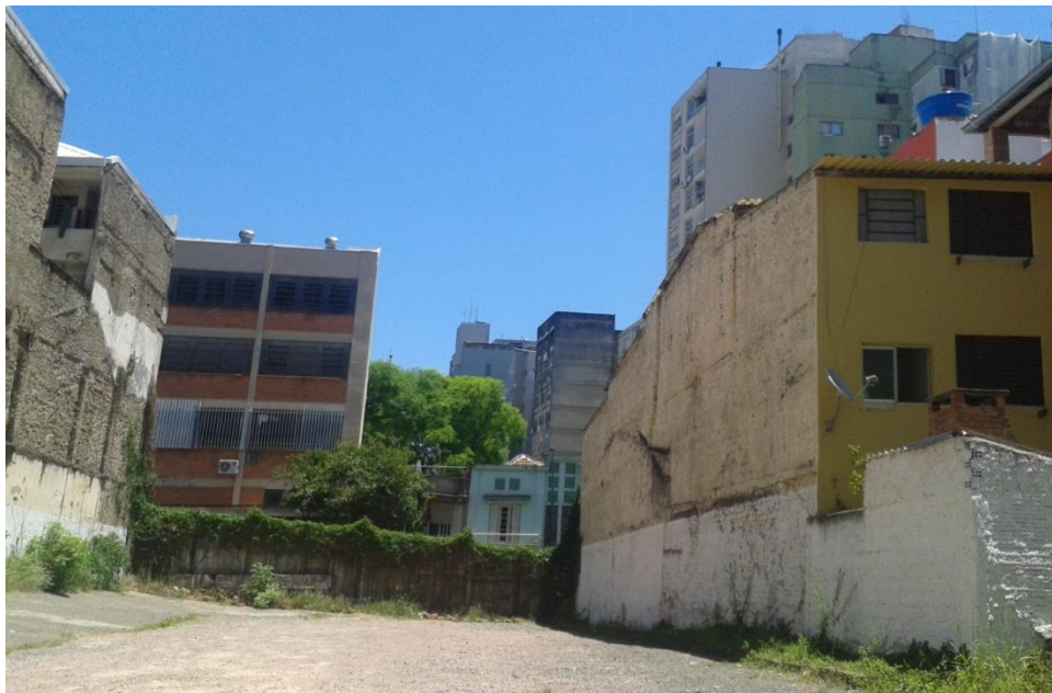
Figura 63 – Vistas do lote internamente
