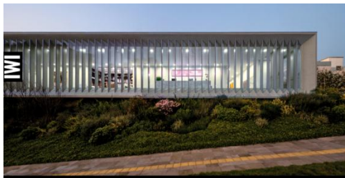
Figura 4 – Fachada Sudoeste Instituto Ling
