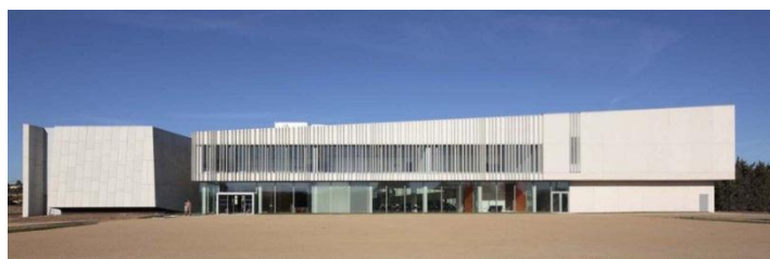
Figura 39 – Fachada oeste da escola
