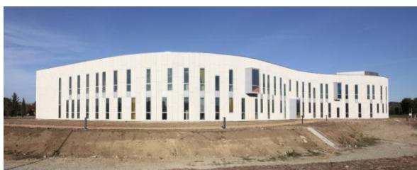
Figura 37 – Fachada oeste da escola
