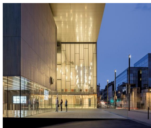
Figura 30 – Detalhe da iluminação
