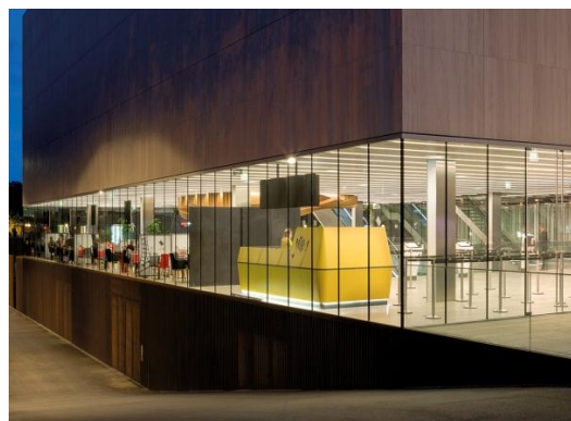
Figura 32 – Vista da edificação
