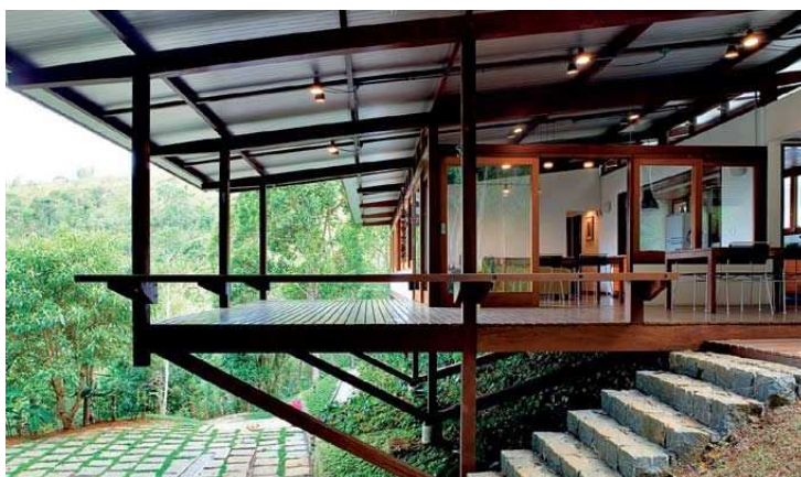
Figura 72 – Exemplo de estrutura metálica
