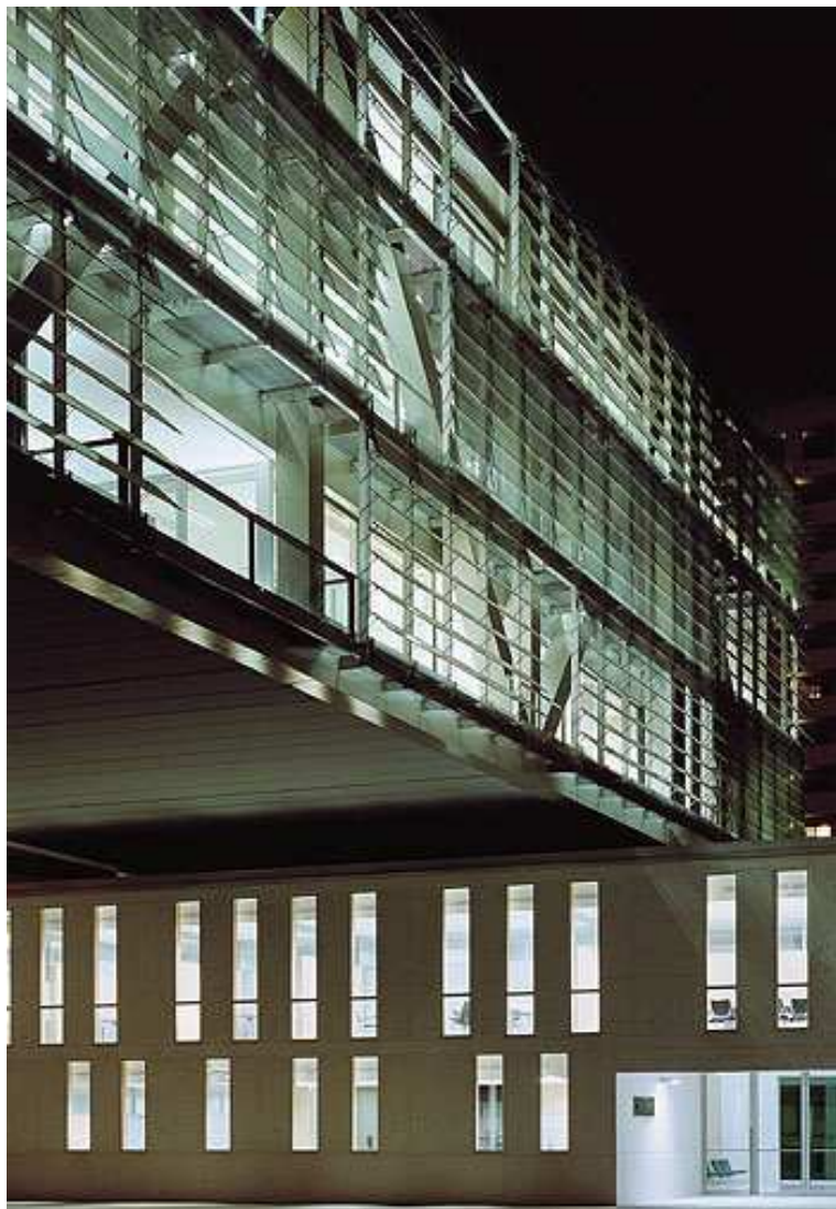
Imagem 11: Fachada térreo e detalhe da estrutura metálica Fonte: Camarasa, 2009.
