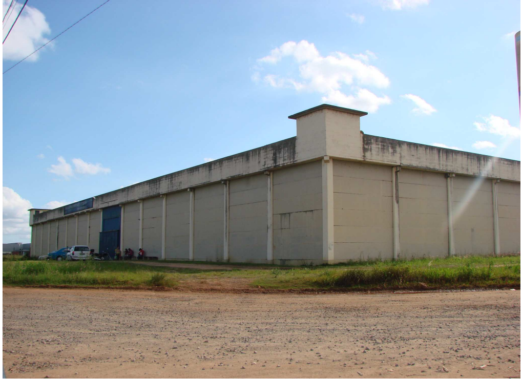
Imagem 8: Fachadas da CASE de Novo Hamburgo. Fonte: Autora, 2009.
