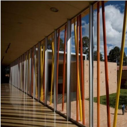
**Figura 45 – Imagem da fachada com brises coloridos**
