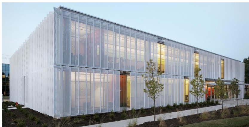
Figura 41 - Fachada do edifício
