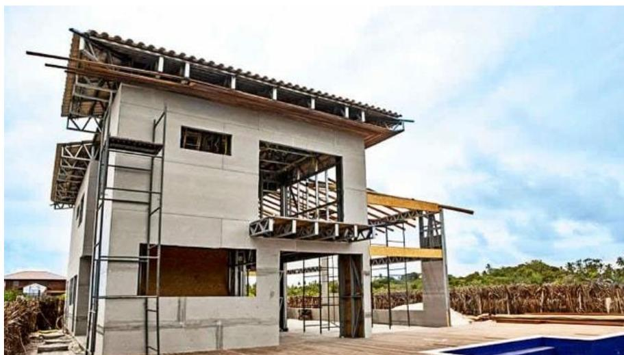
Figura 90 – Método construtivo em Steel Frame
