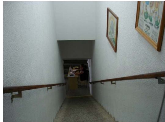
Imagem 08: Escada de acesso ao 2º pavimento
