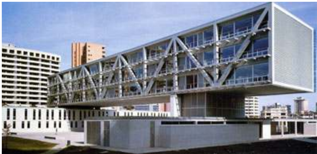
Imagem 45: Estrutura metálica aparente no volume superior. Fonte: CONTRAPUNTO, 2009.
