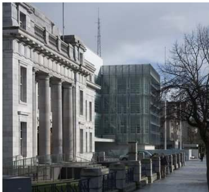
Imagem 35: Vista do prédio da câmara e ao fundo a nova seda da prefeitura. ver fonte: Fonte: PROJECT, 2008
