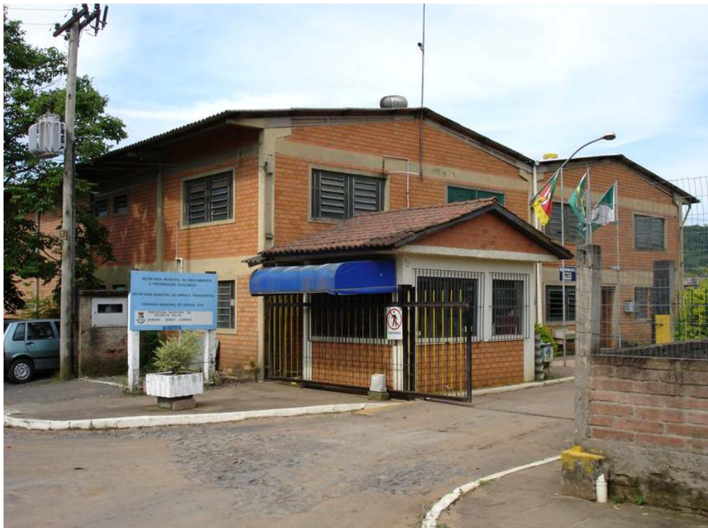
Imagem 21: Edificação que abriga vários setores da prefeitura.
