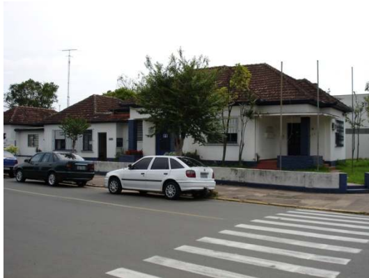
Imagem 15: Fachada da edificação
