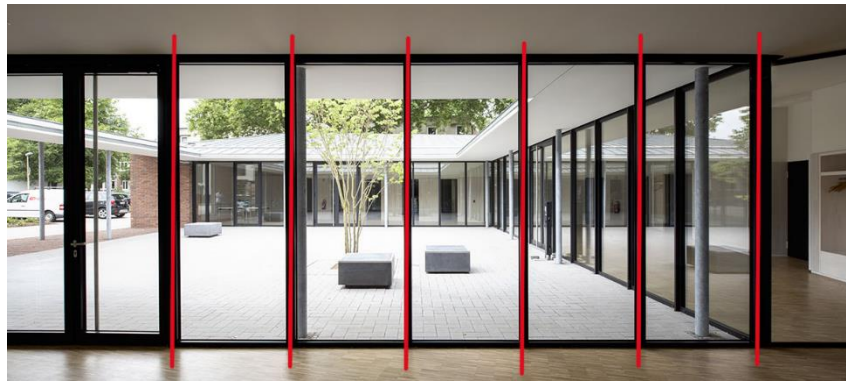
Figura 50 – Vista do interior para o pátio.
