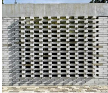
Figura 66 – Bloco de concreto aparente.
