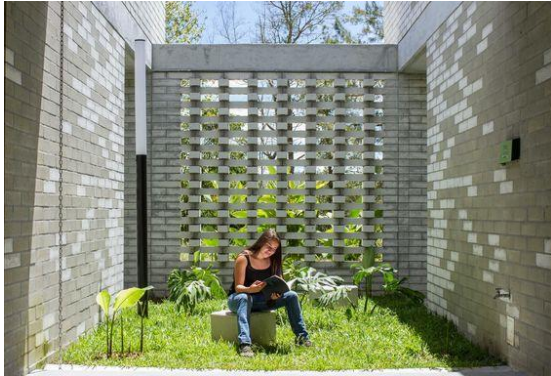
Figura 65 – Vedação com bloco de concreto.
