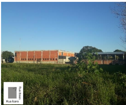
Figura 27 – Vista do alto da Rua Ibsen.
