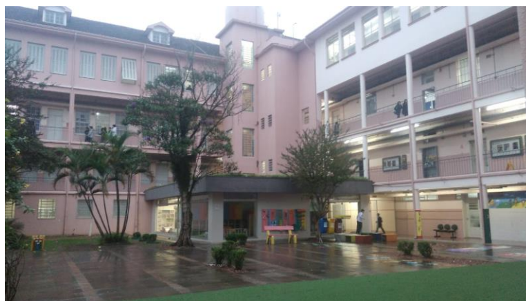
Imagem 5 - Área interna escola
