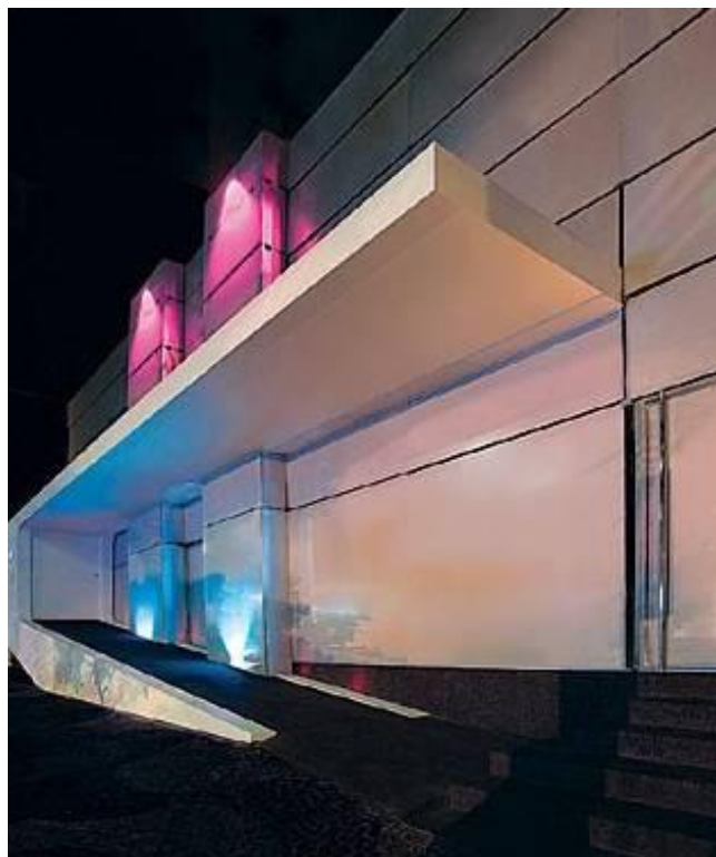
Figura 41 - Rampa de acesso Fonte: ARCOWEB, 2009
