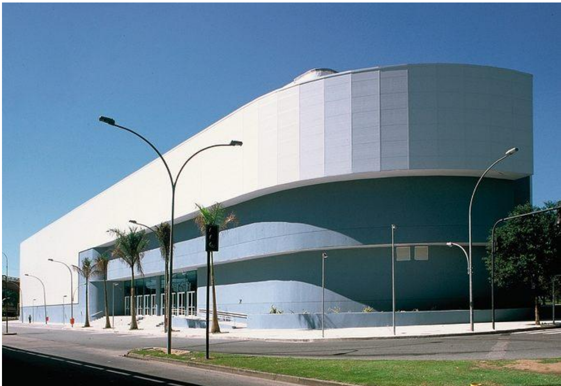
Figura 62 - Imagem das placas metálicas já instaladas. Sua aparência é muito semelhante com o concreto aparente Fonte: METÁLICA, 2009
