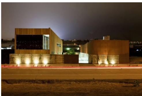
Figura 80 - Vista da fachada frontal
