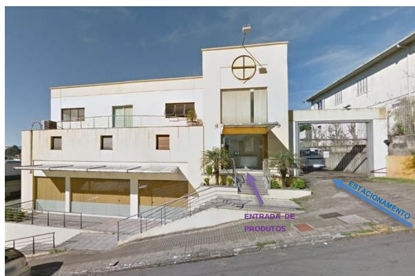
Figura 14 - Vista da Rua Carlos Flores
