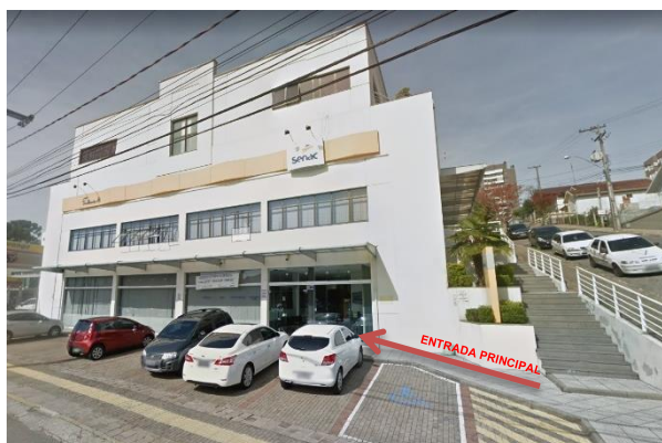
Figura 13 – Vista da Rua Saldanha Marinho
