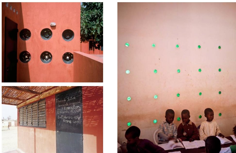
Figura 31: Fotos que mostram os aros de rodas de carros, parede com garradas de vidros verde, e esquadrias metálicas.
