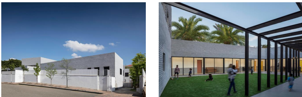
Figura 20: Fachada externa e fachada interna, respectivamente.
