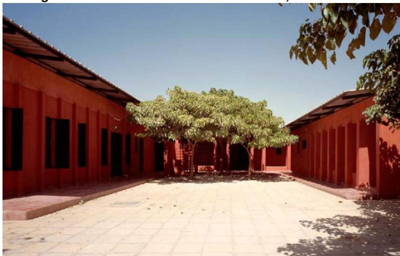
Figura 29: Foto do centro visto de frente, em forma de U.
