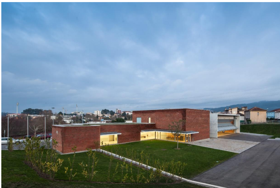
Figura 28 – Quartel dos Bombeiros de Santo Tirso.
