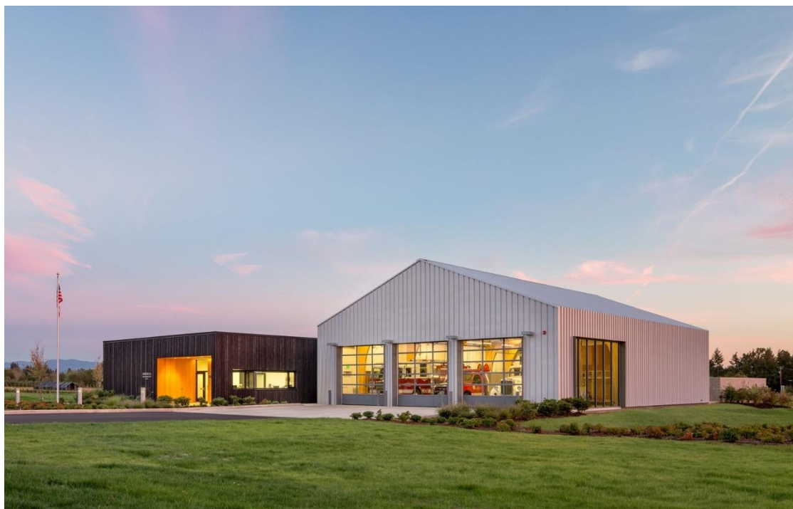
Figura 42 – Fachada dos edifícios.
