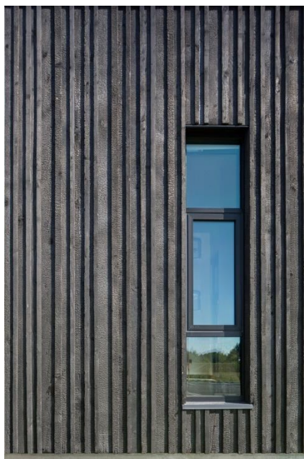
Figura 41 – Imagem da fachada com técnica Shou Sugi Ban.
