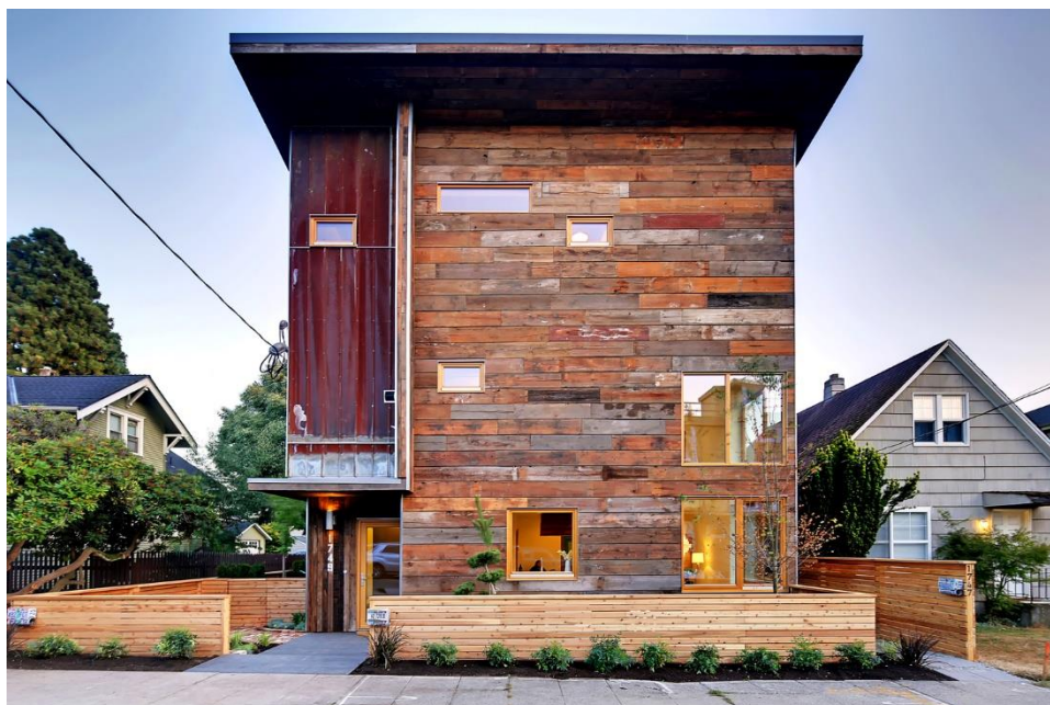
Figura 53 – Fachada com madeira de demolição.
