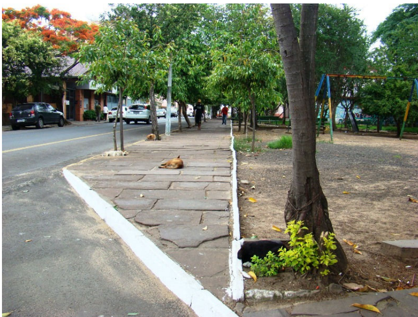
Imagem 11 - Vista da única testada livre na Praça da Bandeira, com cachorros de rua, passeios desnivelados e falta de pavimentação no interior da praça.
