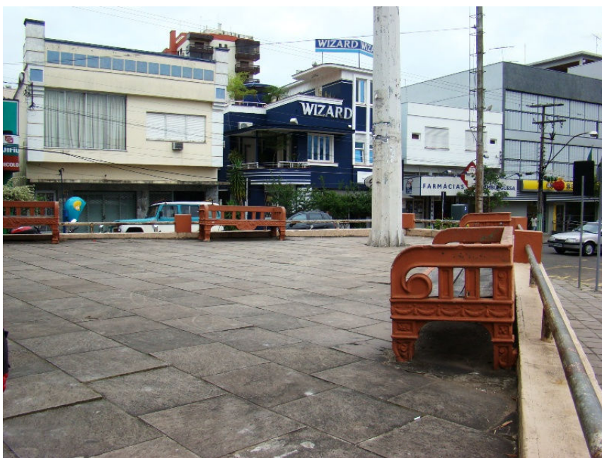
Imagem 05 - Bancos instalados na Praça Marechal Deodoro, pouco utilizados devido à localização.
