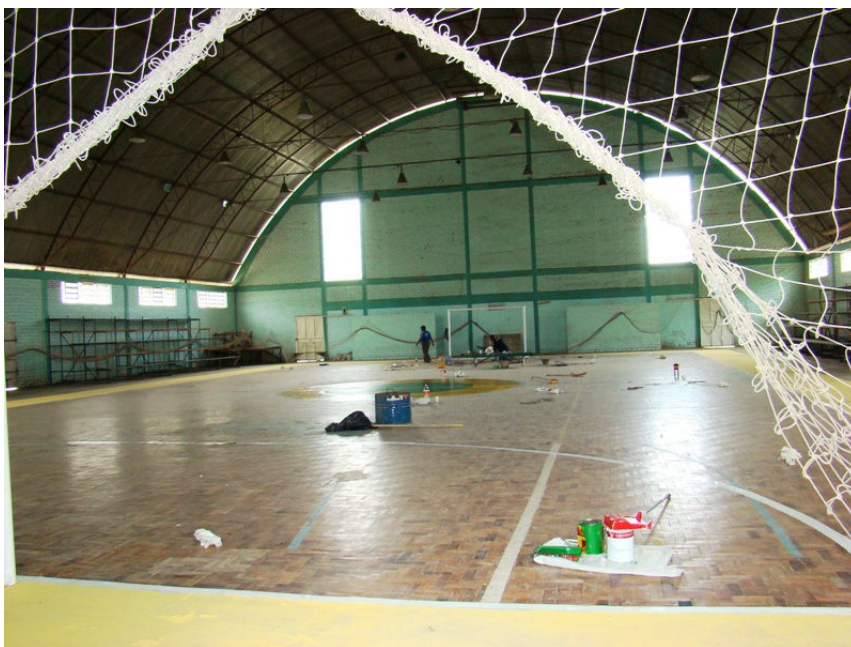
Imagem 29 - Vista interna do Ginásio Municipal localizado no Parque do Trabalhador de Taquara.
