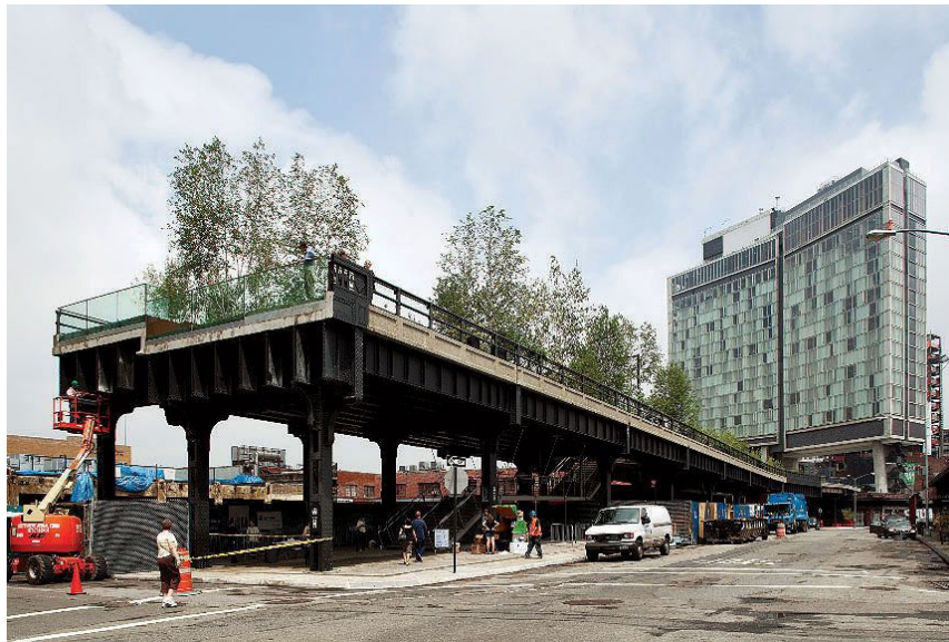
Imagem 49 - Vista do High Line Park, implantado em linha férrea elevada desativada. Fonte: PLATAFORMA ARQUITECTURA, 2009a
