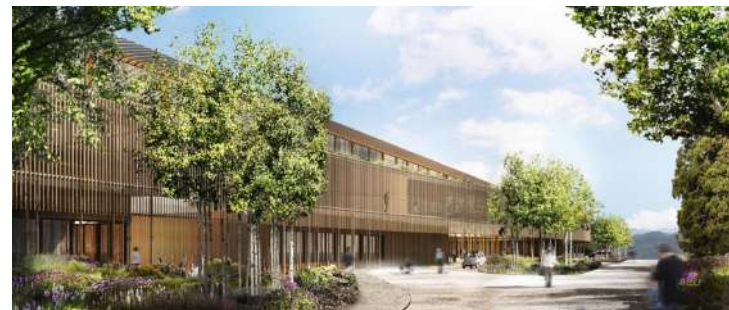
Figura 55 - Fachada Centro Hospitalar
