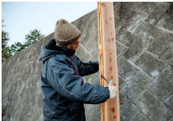
Figura 101: Técnica com maçarico
