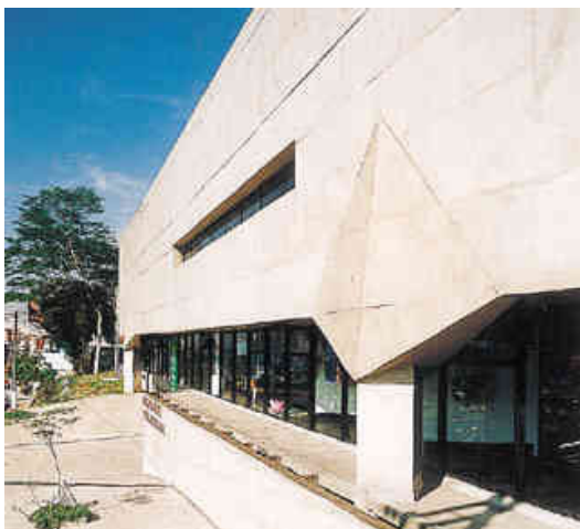
Figura 70: Encontro do pilar com o corpo Fonte: (ARCOWEB, 2009)
