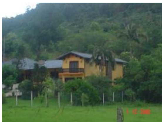
Figura 44: Casa de dois Pav. Fonte: Autora
