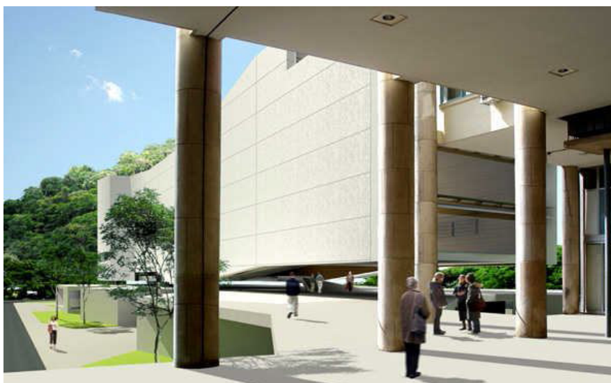
Figura 68: Pilotis demarcando a entrada Fonte: (ARCOWEB, 2009)
