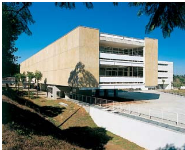
Figura 85: Biblioteca e Ambulatório Fonte: (ARCOWEB, 2009)
