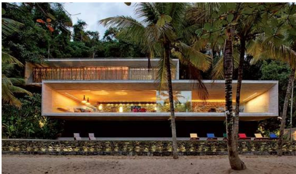
Figura 83: Casa em Paraty: sobrepostos e independentes Fonte: (ARCOWEB, 2009)
