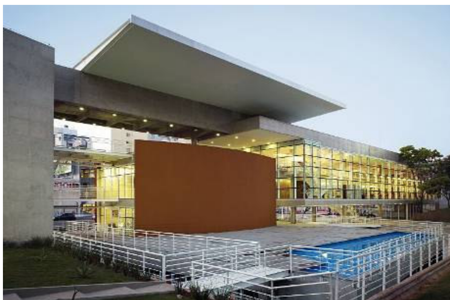
Figura 54: A cobertura do bloco do telecentro ultrapassa em largura e altura a da biblioteca, protegendo o terraço e sombreando o térreo. Fonte: (ARCOWEB, 2009)
