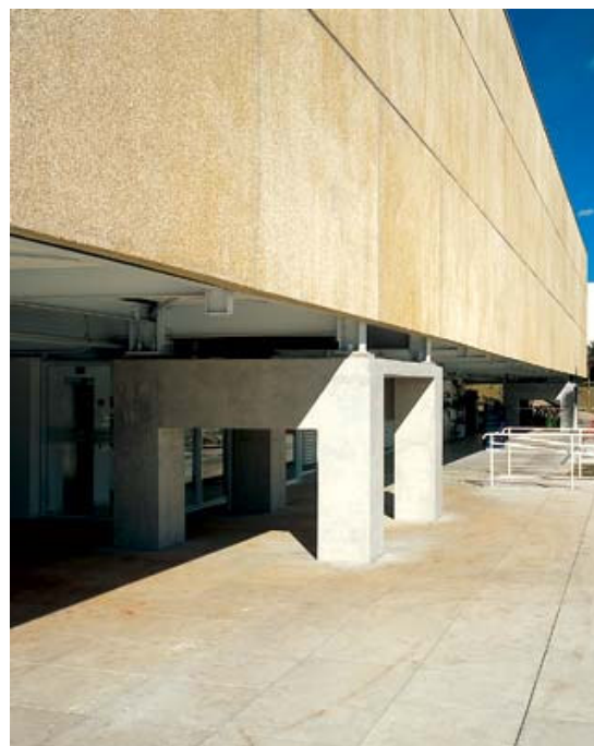
Figura 88: Pilotis Fonte: (ARCOWEB, 2009)
