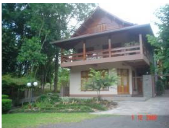
Figura 42: Casa de dois Pav. Fonte: Autora
