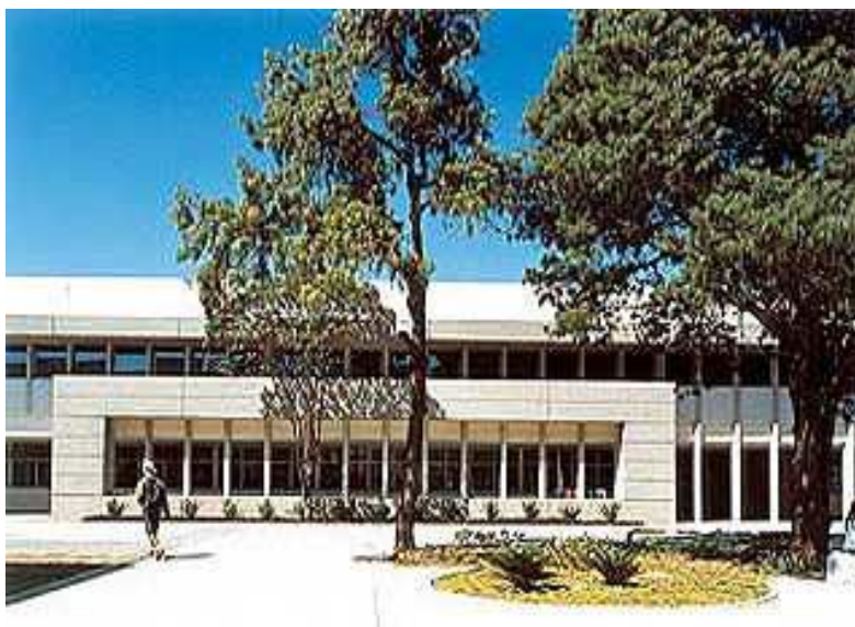
Imagem 107: Painéis pré-fabricados definem a nova linguagem do edifício com salas de aulas (CORBIOLI, 2009d).
