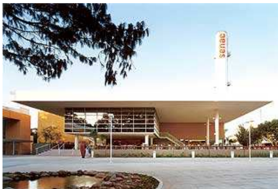
Imagem 100: O novo edifício, para o curso de gastronomia, tem estrutura em concreto convencional e pré-fabricado (CORBIOLI, 2009d).
