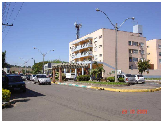
Imagem 64: Visual do entorno do lote a partir da Avenida Sete de Setembro.
