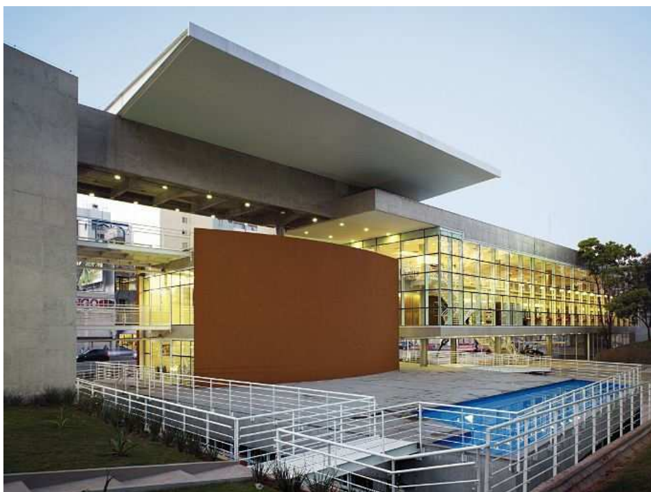
Imagem 85: A cobertura do bloco do telecentro ultrapassa em largura e altura a da biblioteca, protegendo o terraço e sombreando o térreo (MELENDEZ, 2009b).
