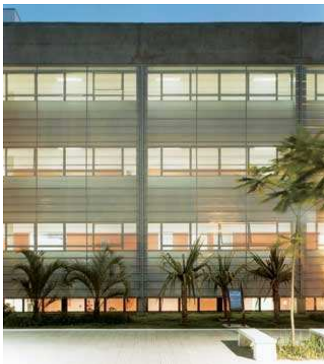
Imagem 89: A fachada norte esclarece o partido da implantação linear. O pavimento semi enterrado tem janelas altas, junto do piso do pátio central (GRUNOW,2009c).
