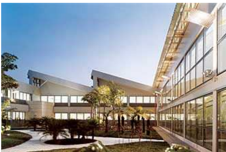
Imagem 103: A abertura de pátios no interior do prédio acadêmico assegurou luz e ventilação naturais a todas as salas de aulas (CORBIOLI, 2009d).
