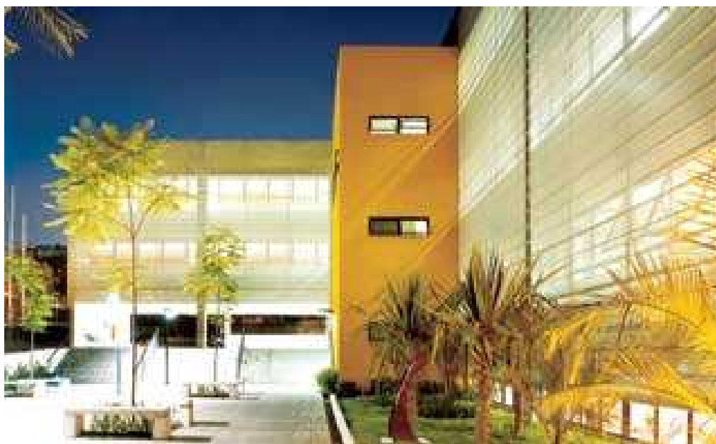
Imagem 92: O fechamento externo dos corredores das salas de aulas é feito por brises metálicos, alternadamente perfurados e sólidos (GRUNOW,2009c).
