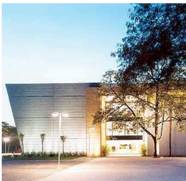
Imagem 106: Edifício da biblioteca: fechamento em pré-moldados de concreto com Acabamento texturizado (CORBIOLI, 2009d).
