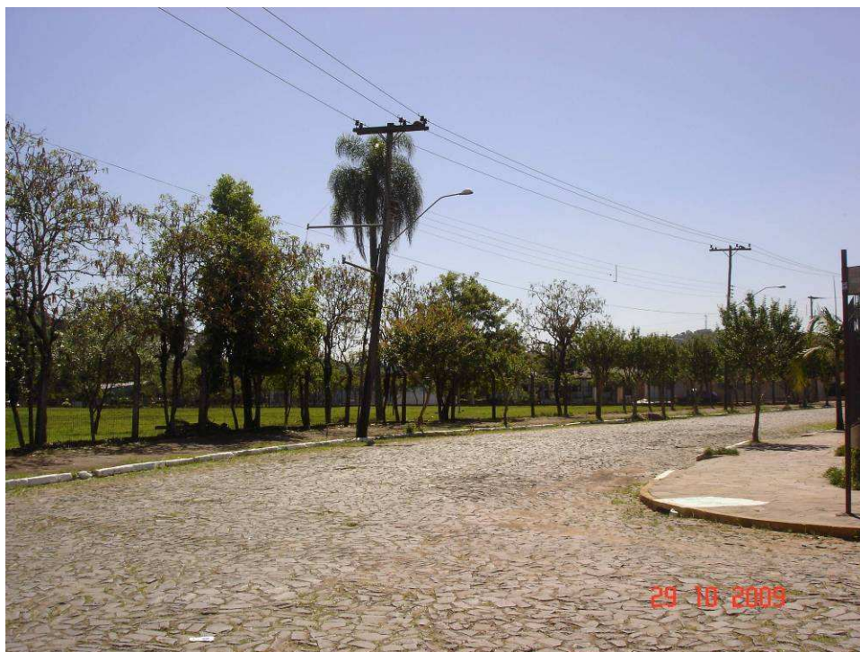
Imagem 70: Visual das ruas que circundam o lote que não são pavimentadas.
