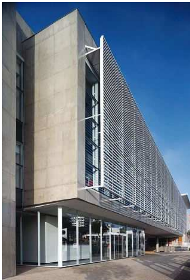
Imagem 78: Brise metálico horizontal (ARCOWEB, 2009a)
