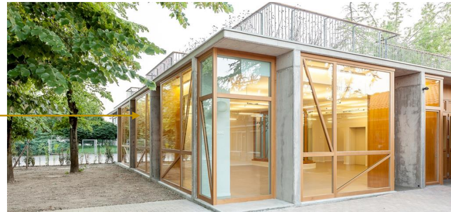
Figura 10: Vista da edificação.
