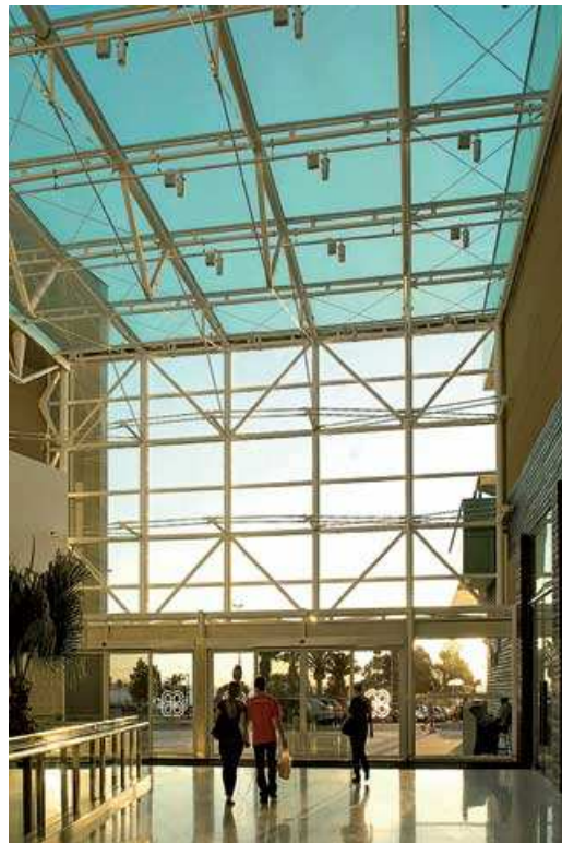
(Imagem 41: Estruturação dos vidros - Barra Shopping Sul – Arco web, 2008). (Fonte: http://www.arcoweb.com.br/arquitetura/arquiteto-paulo-baruki-barra-shopping-sul-09-09-2009.html )
