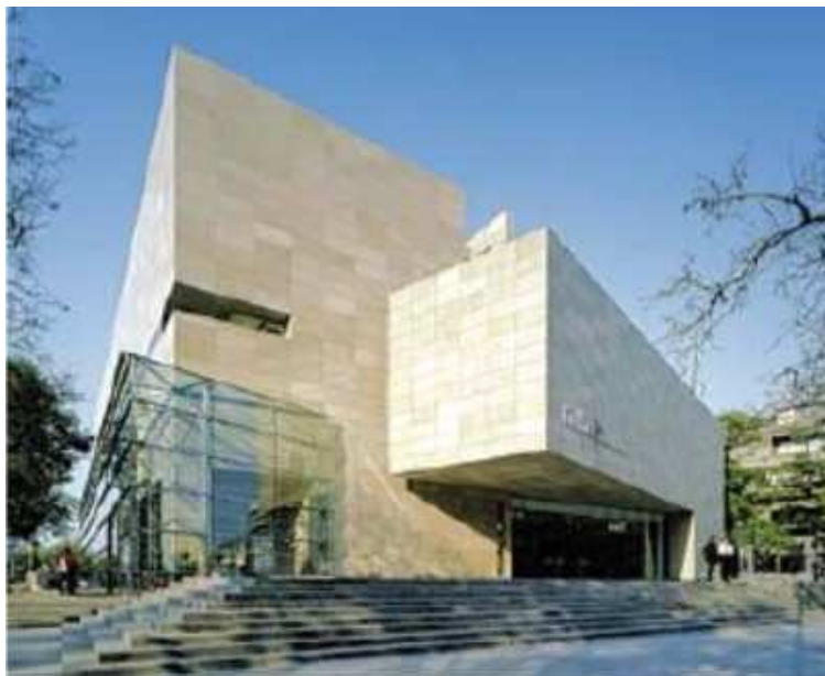
Imagem 41 – Malba vista da fachada principal. (SARZABAL, 2007.)
