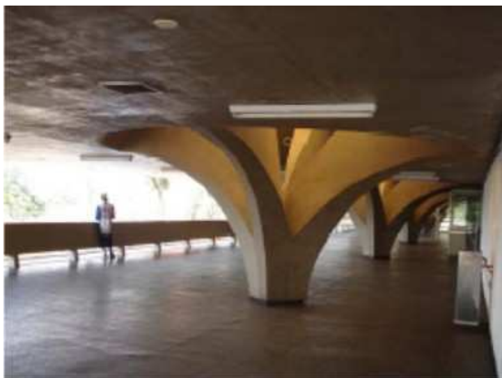
(Imagem 34 – abertura zenital nos pilares)
