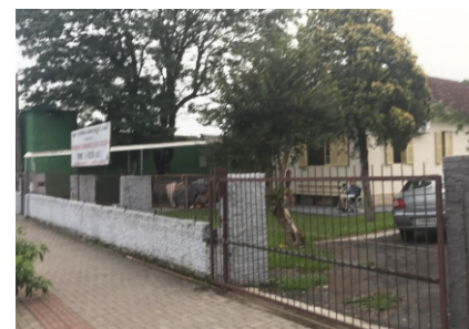
Figura 23: Fachada frontal do residencial. Fonte: Autora, 2019.
