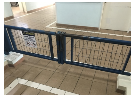
Figura 20: Fechamento da escada. Fonte: Autora, 2019.
