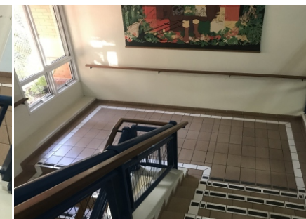
Figura 21: Escada. Fonte: Autora, 2019.
