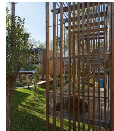
Figura 47 - Revestimento com ripas de madeira.
