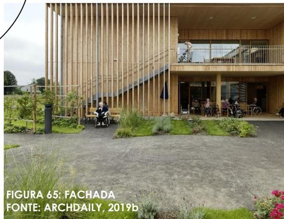
Este lar foi construído como uma casa pré-fabricada, todo em madeira laminada (Figuras 65 e 66).
