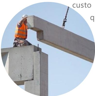
Figura 68 | Concreto armado pré-fabricado.
