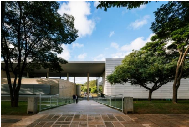
Figura 54: Rampa de acesso a Biblioteca vista da fachada sul. Fonte: archdaily (2019c).
