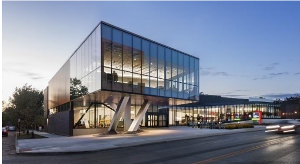
Figura 79: Perspectiva Biblioteca de Northside. Fonte: Archdaily (2019e).
