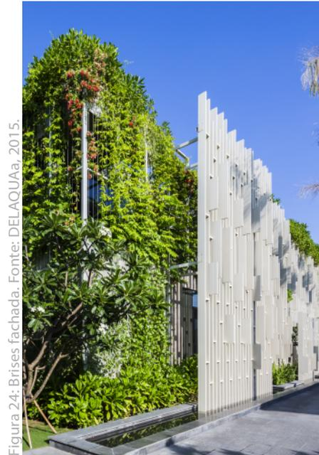
Figura 24: Brises fachada. Fonte: DELAQUAa, 2015.
