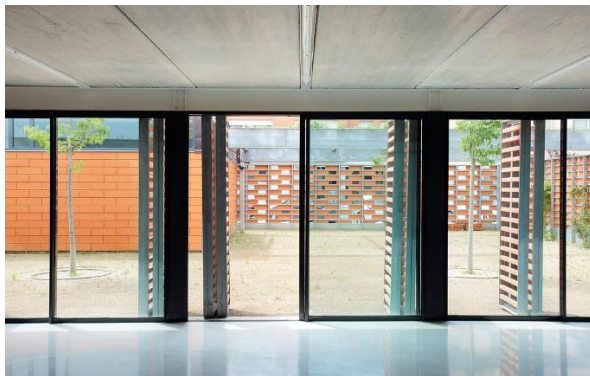
Figura 33 – Aberturas em vidro
