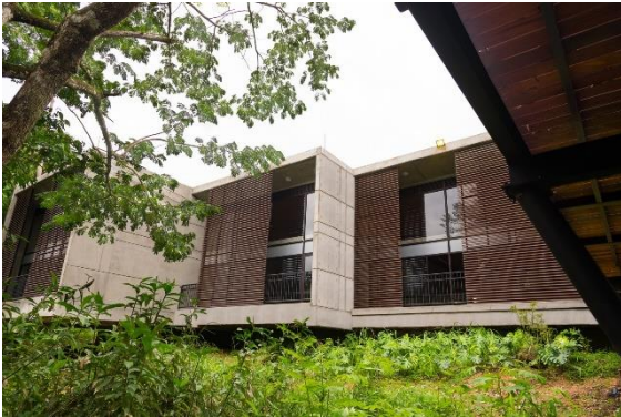
Figura 11 – Fachadas com grandes aberturas e o uso do concreto pré-moldado
