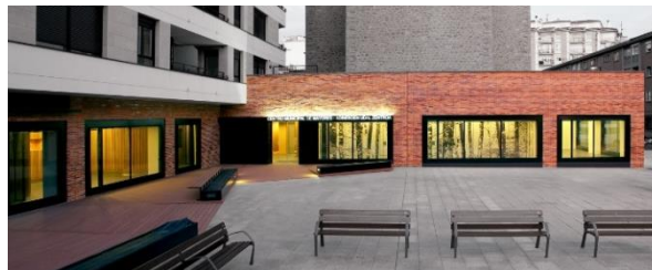
Figura 06 – Aberturas na fachada
