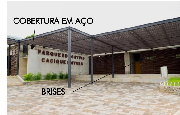
Figura 10 – Brises e Telhado
