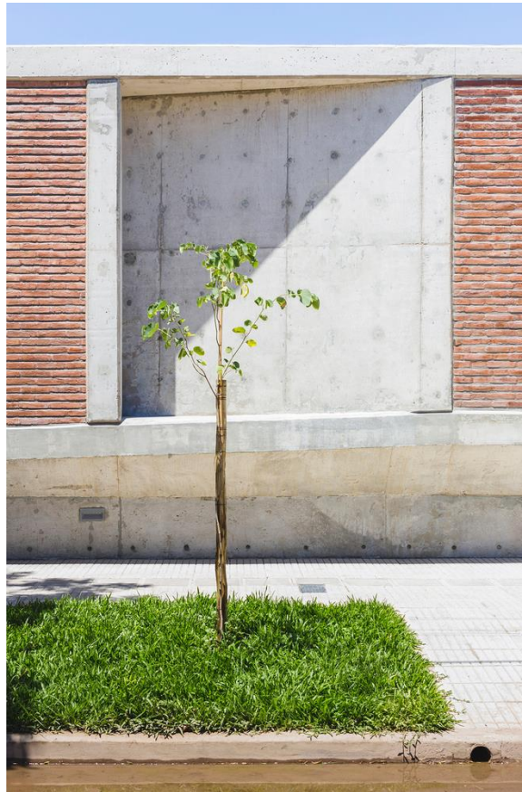
Figura 14 – Uso de placas de concreto pré-moldadas
