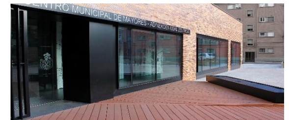
Figura 07 – Aberturas na fachada
