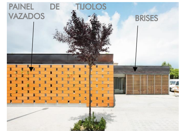
Figura 36 – Brises e painel de tijolos vazados
