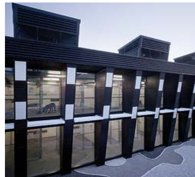
Figura 57: Edifício-canil. Fonte: HOLYWESTIE, 2019.
