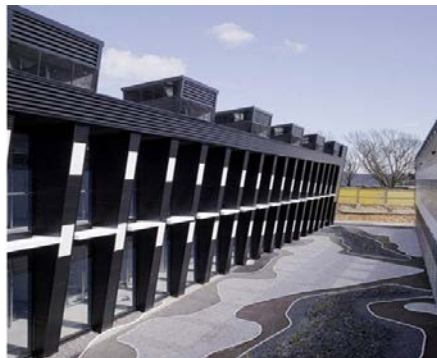
Figura 56: Edifício-canil. Fonte: HOLYWESTIE, 2019.
