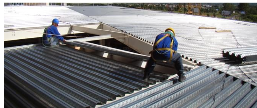
Figura 97: Laje Steel deck . Fonte: AECWEB, 2018.
