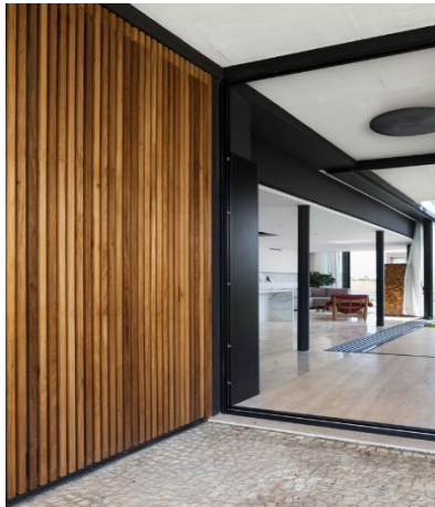
Figura 99: Madeira e perfil. Fonte: AECWEB, 2018.
