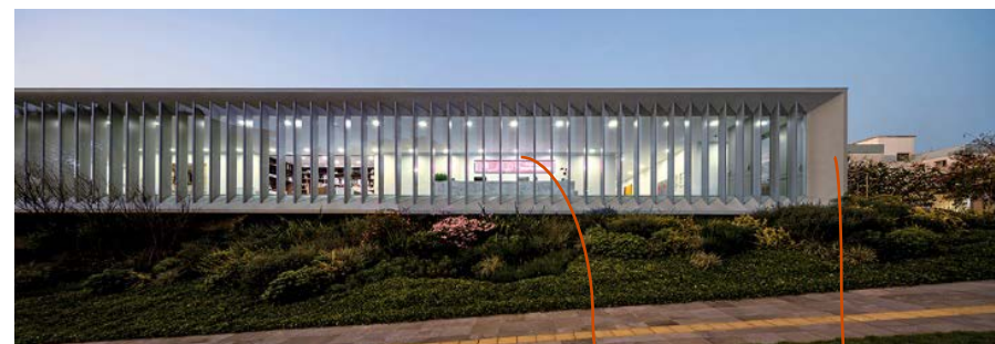
Figura 60: Fachada principal. Fonte: ARCHDAILY, 2019.
