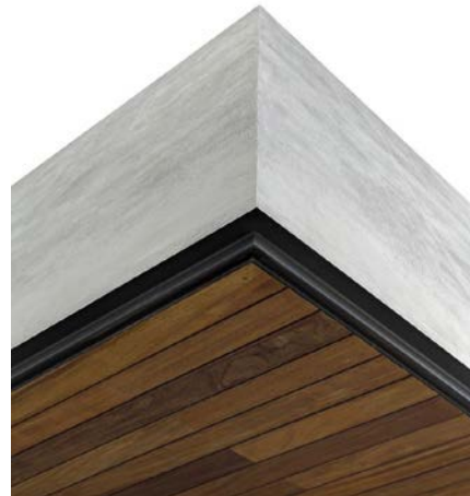
Figura 100: Madeira e concreto. Fonte: AECWEB, 2018.
