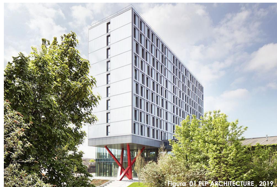
Figura 1 demonstrando a fachada e acesso principal do Co-living Old Oak, o maior do mundo, com mais de 500 quartos. (PLP ARCHITECTURE, 2019)
