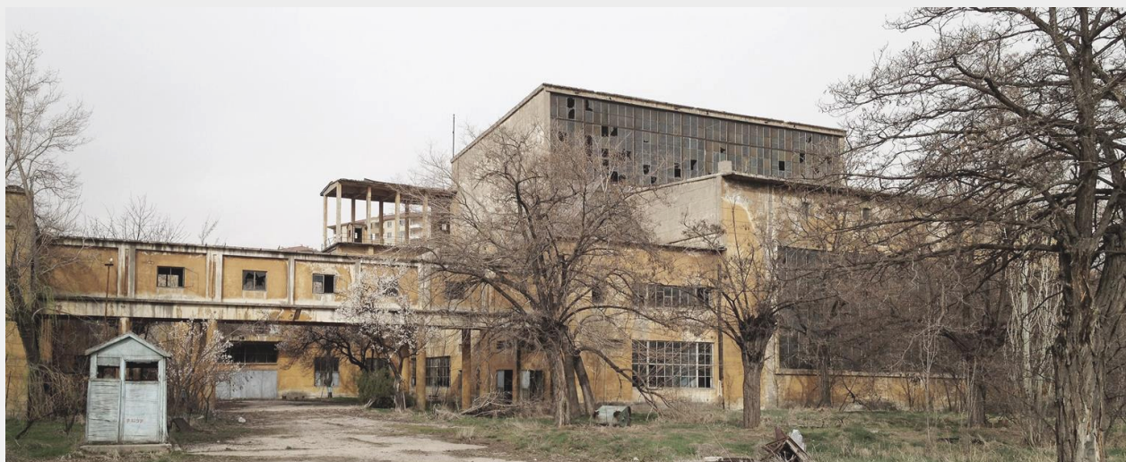
Fig. 08, Estado em que a edificação se encontrava antes do processo de Retrofit (EMRE AROLAT ARCHITECTS, 2019).
