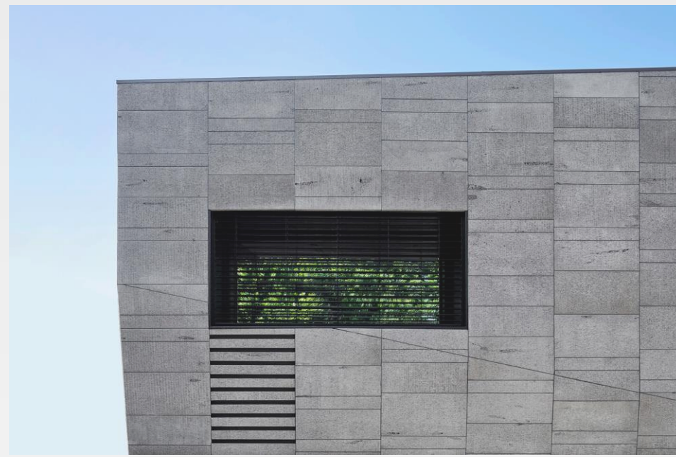
Fig. 32: Centro De Música Victor McMahon (BALDASSO CORTESE ARCHITECTS, 2019). Fig. 33: Detalhe da fachada – Placas de zinco (BALDASSO CORTESE ARCHITECTS, 2019).
