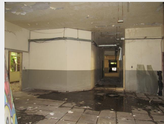
Fig. 72: Circulação com grande área de infiltração (ARQUIVO PESSOAL, 2019).
