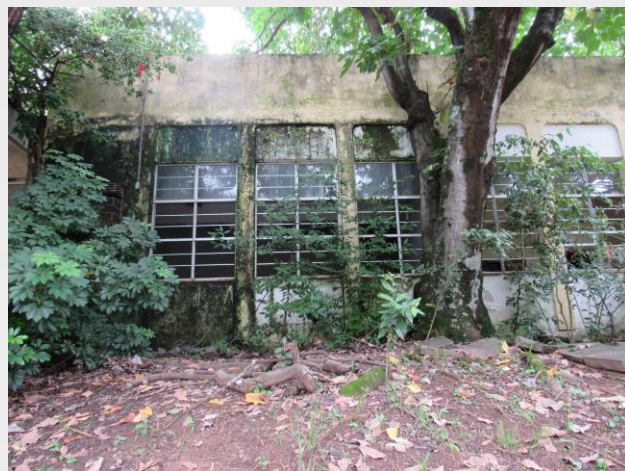
Fig. 66: Fachada Rua 3 de outubro (ARQUIVO PESSOAL, 2019).
