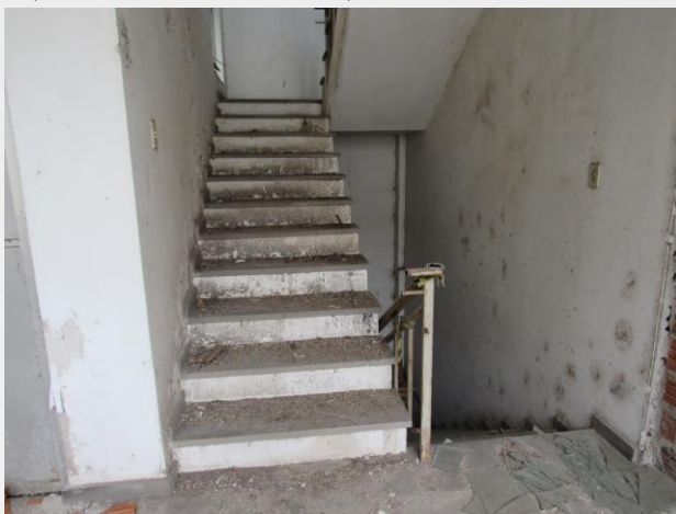
Fig. 75: Escada secundária. Conecta todos os pavimentos (ARQUIVO PESSOAL, 2019).
