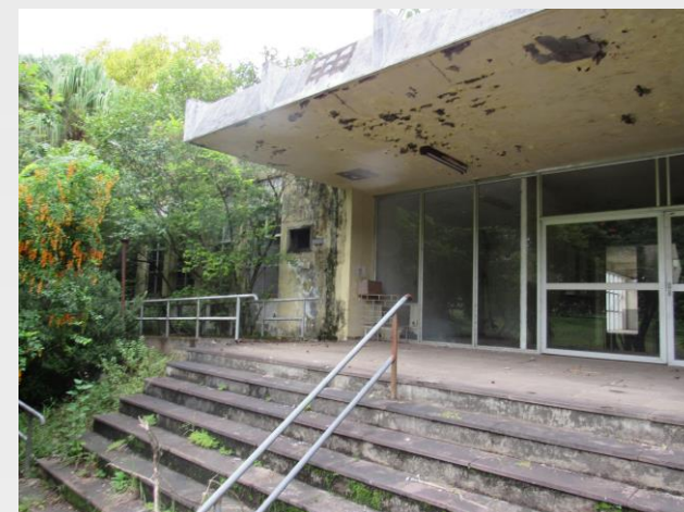
Fig. 68: Acesso principal Rua 3 de outubro (ARQUIVO PESSOAL, 2019).
