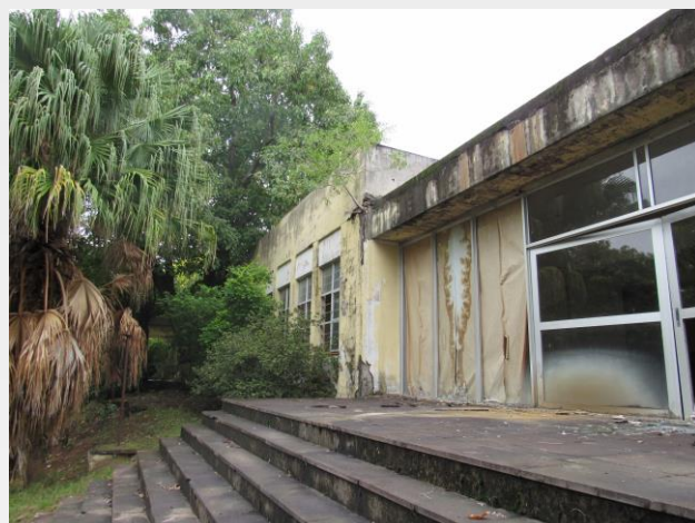
Fig. 67: Acesso ao auditório (ARQUIVO PESSOAL, 2019).
