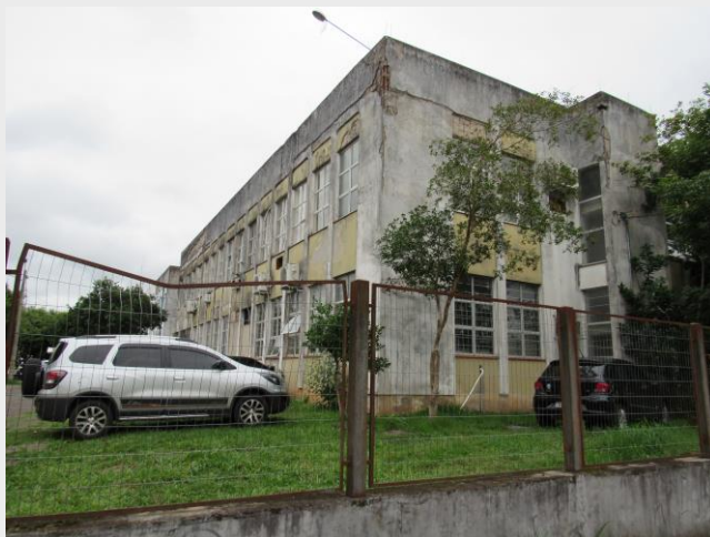
Fig. 62. Parte que não será utilizada pelo projeto (ARQUIVO PESSOAL, 2019).
