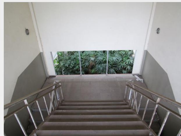
Fig. 77: Escada principal, conecta o térreo com o 2º pavimento (ARQUIVO PESSOAL, 2019).
