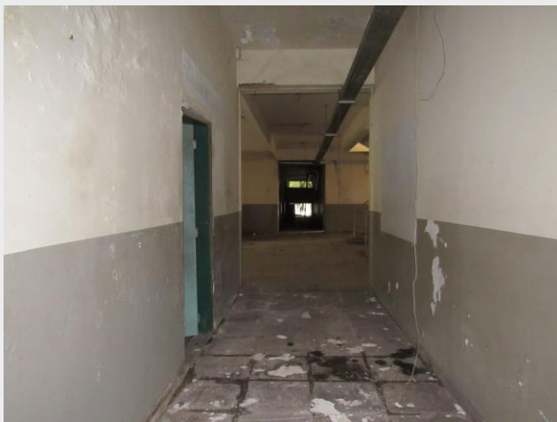
Fig. 74: Corredor que corta o eixo da edificação (ARQUIVO PESSOAL, 2019).
