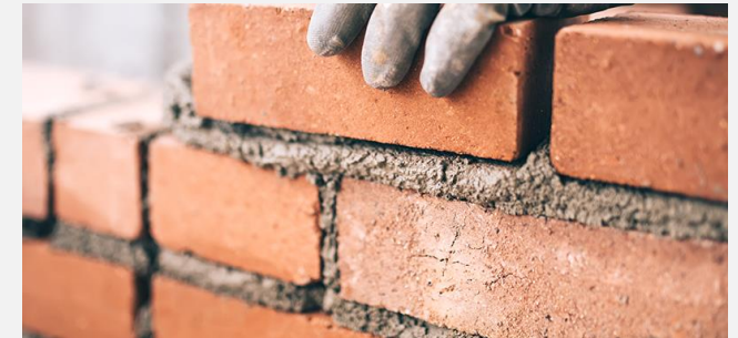
Imagem 54: Alvenaria de tijolos maciços. Fonte: JZ Engenharia, 2018.
