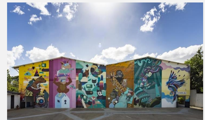
Imagem 9: Fachada dos fundos do hospital veterinário. Fonte: Galeria da arquitetura, 2016.
