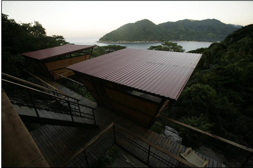
Imagem 56 – Cobertura cabanas com chapa metálica. Fonte: Casas V, PLATAFORMA ARQUITETURA, 2010
