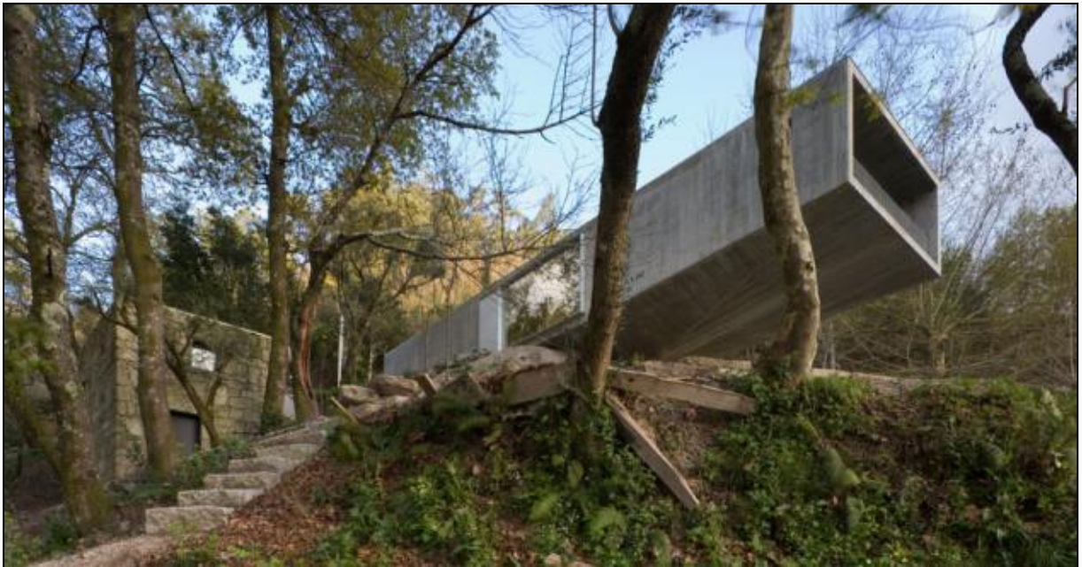
Imagem 40 – Casa em Gerês. Volume em balanço.
