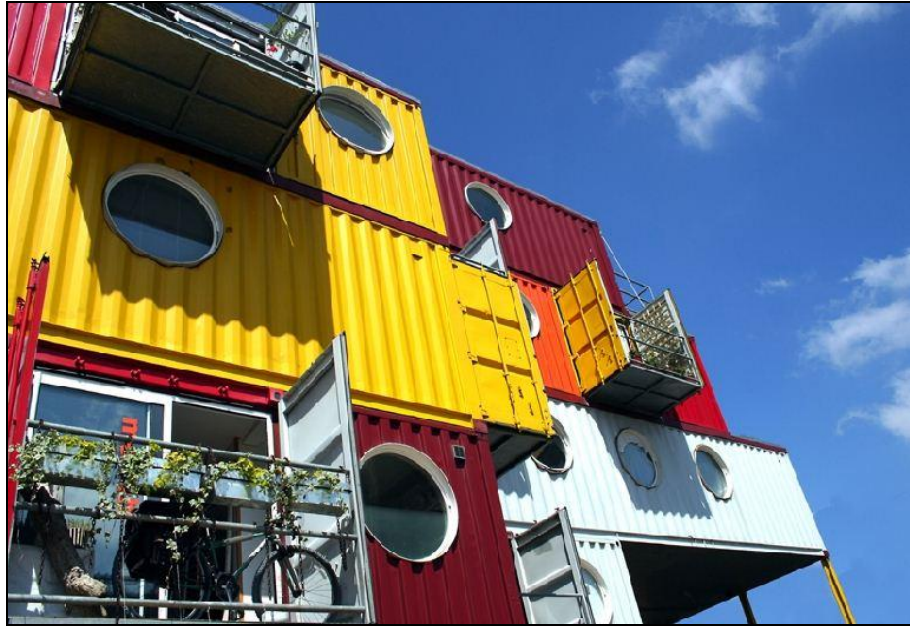
Imagem 34 – Vista externa de projeto residencial feito de Container. Fonte: Urban Space, 2010
