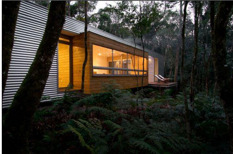
Imagem 08 – Detalhe para materiais e técnicas construtivas.
