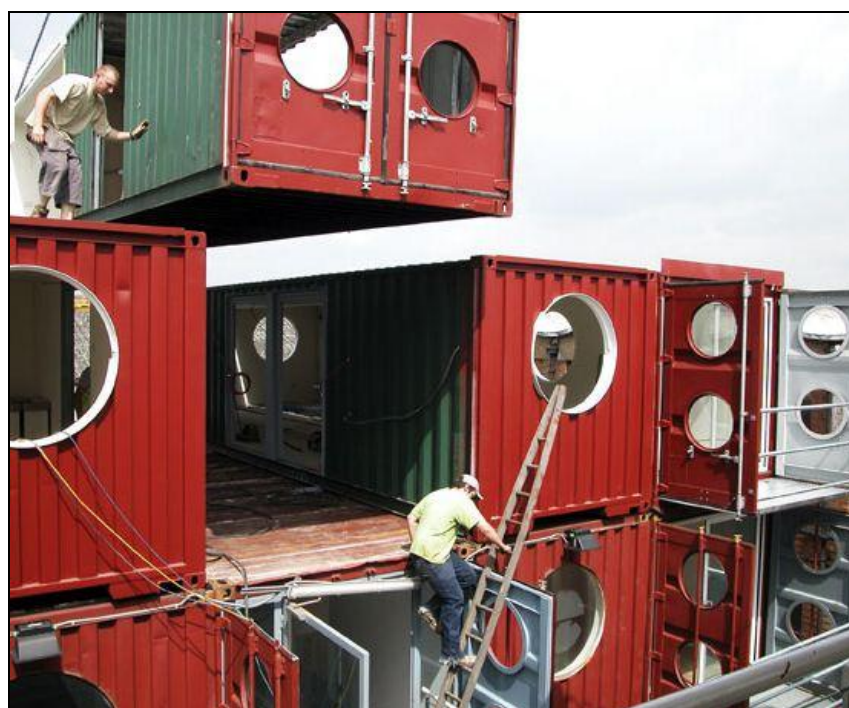
Imagem 33 – Montagem da modulação. Fonte: Urban Space, 2010
