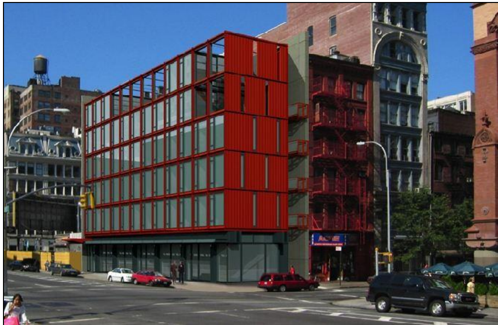
Imagem 39 – Vista externa de hotel feito de Container.
