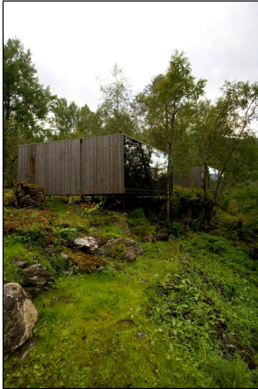
Imagem 59 – Vista externa Hotel. Utilização de vidro e madeira.
