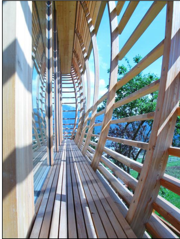
Imagem 44 – Vista externa, detalhe brise.
