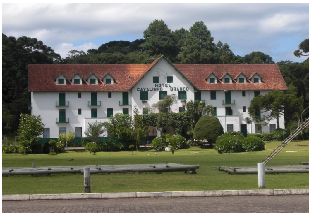
Foto 08 – Fachada principal do hotel Cavalinho Branco.
