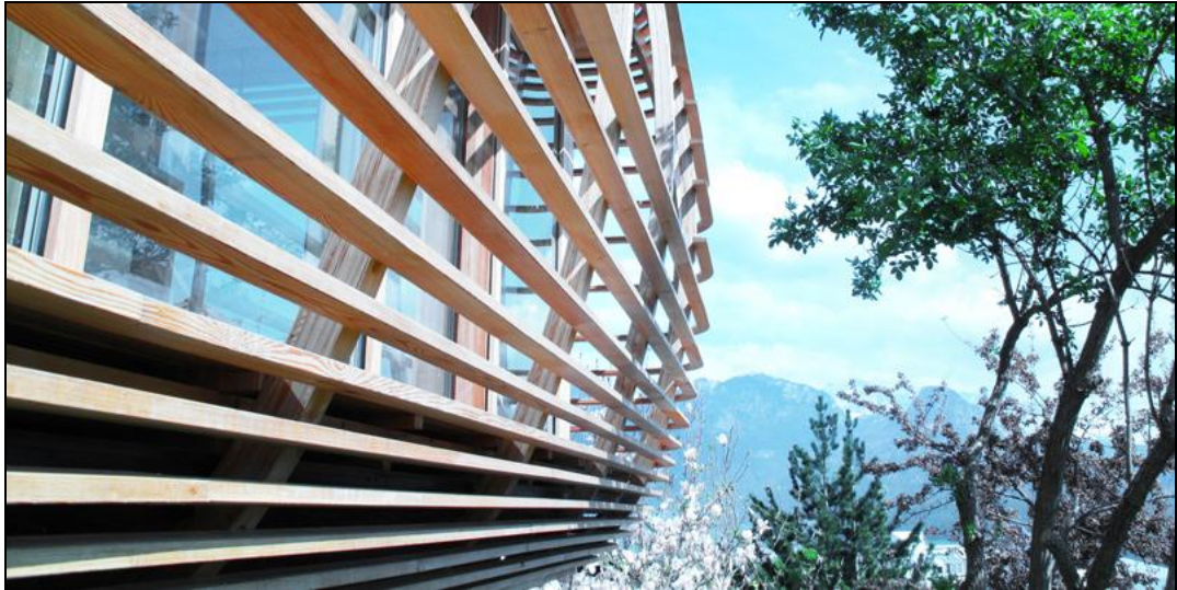
Imagem 46 – Vista externa, detalhe brise.
