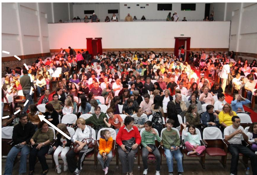
Figura 32– O interior do teatro municipal - paredes sem tratamento acústico
