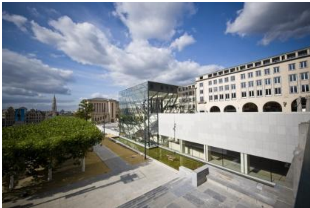
Figura 67– vista externa do auditório Fonte: www.concursosdeprojeto.com.br , acesso em 20/06/2010
