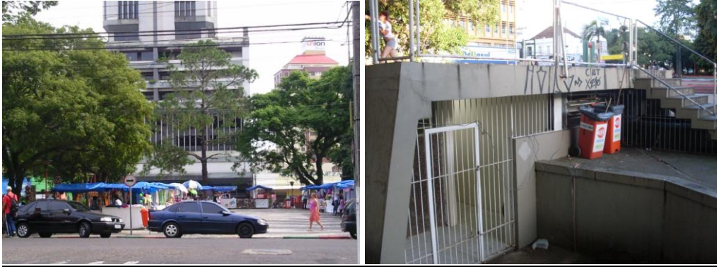
Figuras 5 e 6: Praça do Imigrante atualmente, com comércio informal em sua parte central e o banheiro público desativado
