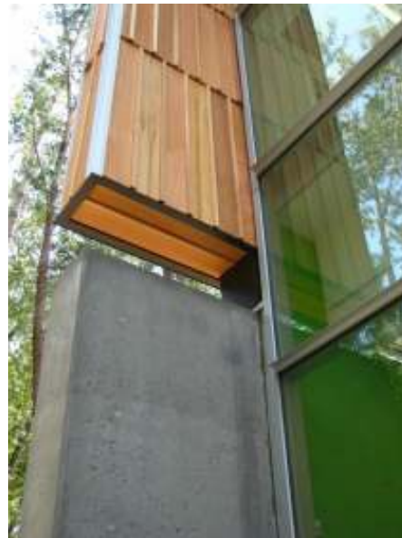
Imagem 3.23: Detalhe 2 da fachada recuada (CONCURSOS DE PROJETO, 2010)
