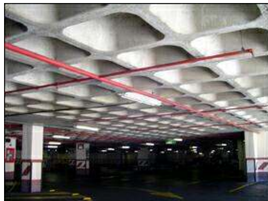
Imagem 7.2: Laje Nervurada (FAU/UFRJ, 2010)
