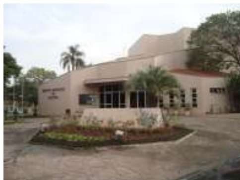
Imagem 5.3: Centro de Cultura, esquina Rua Sete de Setembro e Av. Antão de Farias
