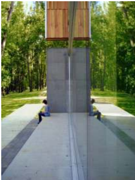
Imagem 3.21: Detalhe da fachada recuada (CONCURSOS DE PROJETO, 2010)
