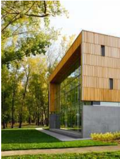
Imagem 3.21: fachada envidraçada recuada (CONCURSOS DE PROJETO, 2010).
