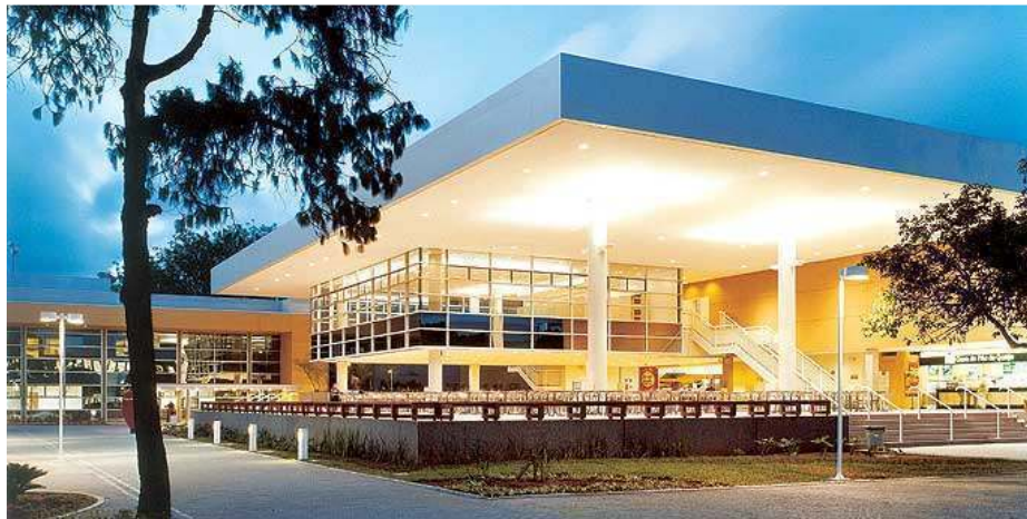
Imagem 7.5: Fachada (ARCOWEB, 2010C)
