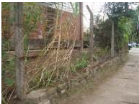
Imagem 5.22: declividade esquina Rua Sete de Setembro e Av. Antão de Farias
