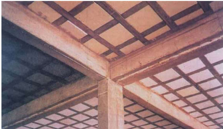
Imagem 7.9: Laje nervurada bidirecional ( FRANCA E FUSCO, 1997, apud RAZENTE, 2003)
