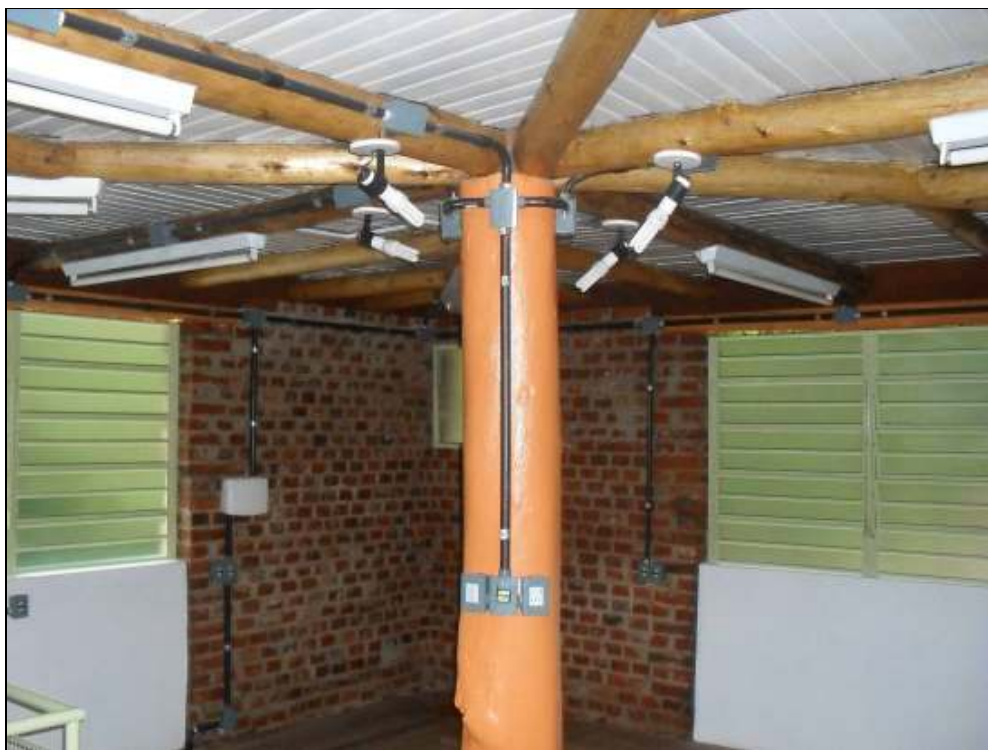
Imagem 46 – Laboratório de Informática – em construção
