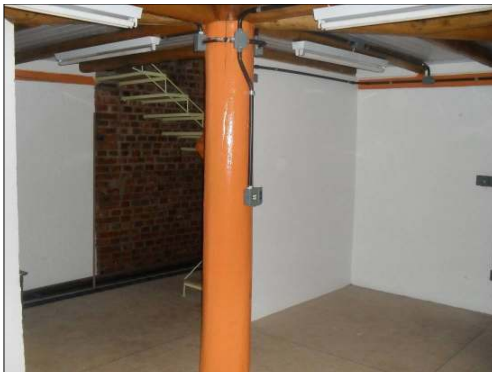
Imagem 45 – Biblioteca – em construção
