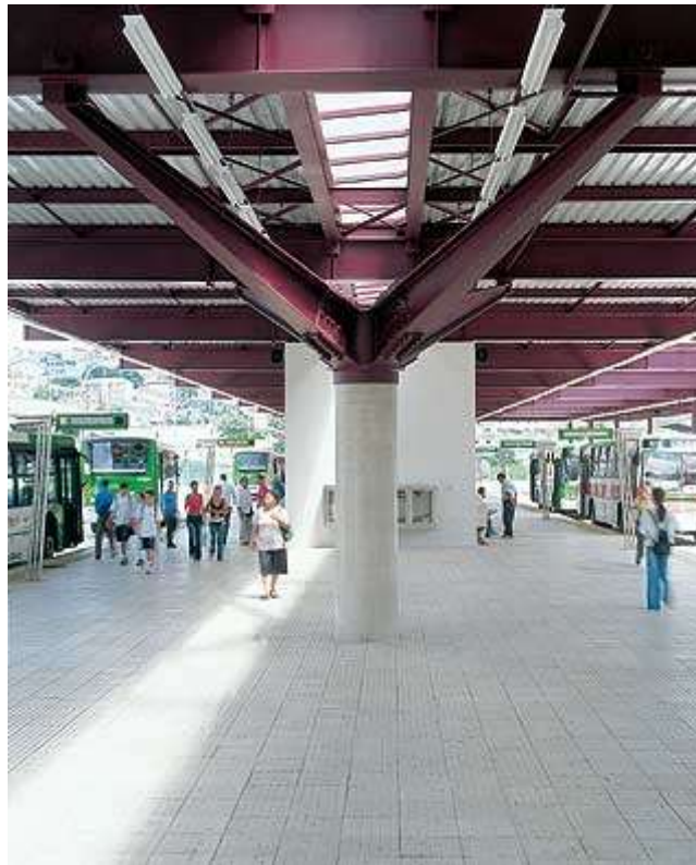
Imagem 75 - Blocos de serviços e pilares que dão suporte à estrutura espacial da cobertura Fonte: ARCOWEB, 2010
