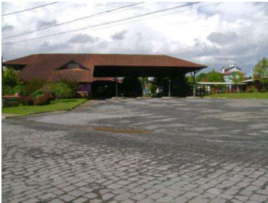
Imagem 6 – Fachada da estação rodoviária atual Fonte: AUTOR, 2010.
