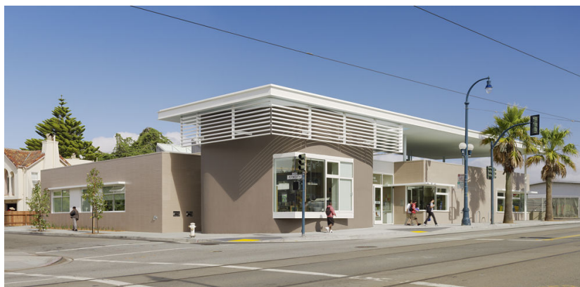
Figura 2.14 – Fachada principal da Biblioteca (FLETCHER, 2009).
