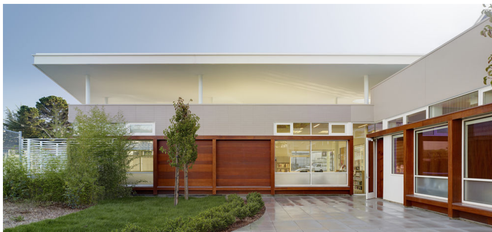
Figura 2.16 – Vista do pátio para a edificação (FLETCHER, 2009).
