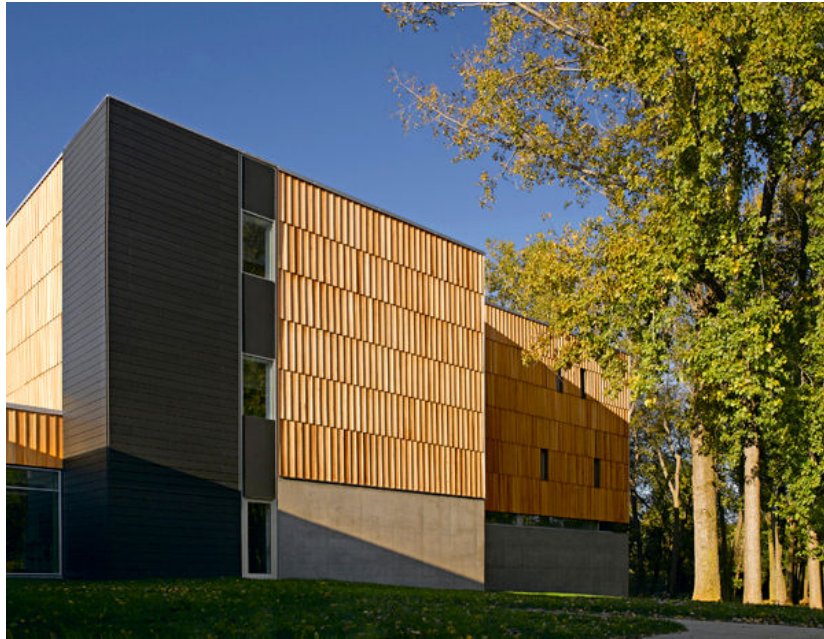
Figura 2.12 – Fachada posterior da biblioteca (PERREAULT, 2010).
