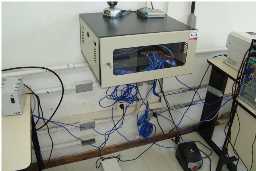
Figura 2.6 – Precariedade na instalação de hardwares
