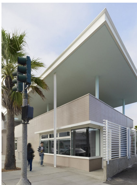
Figura 2.17 – detalhe do sobre-telhado (FLETCHER, 2009).
